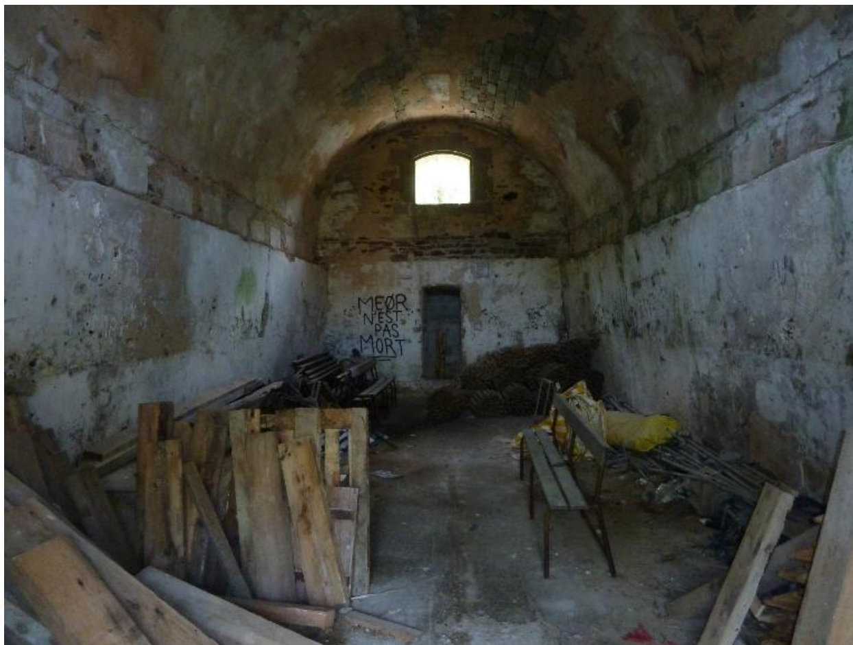
Fort central, Île-d'Houat. Magasin à poudre, intérieur
