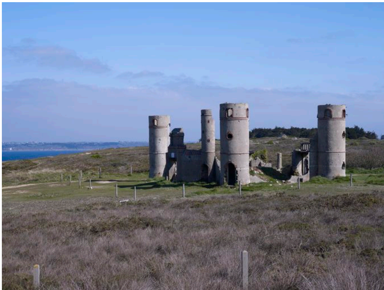
Vestiges de l'ancien manoir du Boulτους, vue prise du nord-ouest
