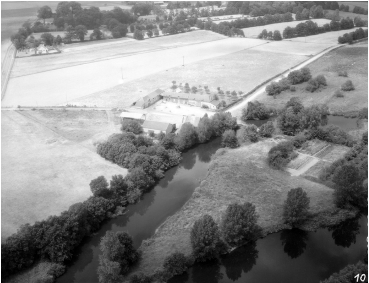
Vue aérienne de situation, prise de l'est.
