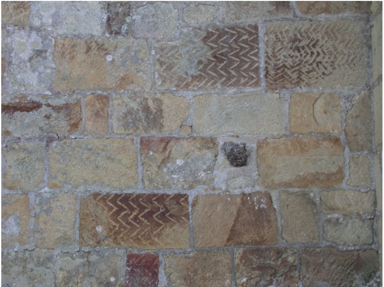
Façade nord, détail de la mise en oeuvre, pierres avec décor taillé en chevrons
