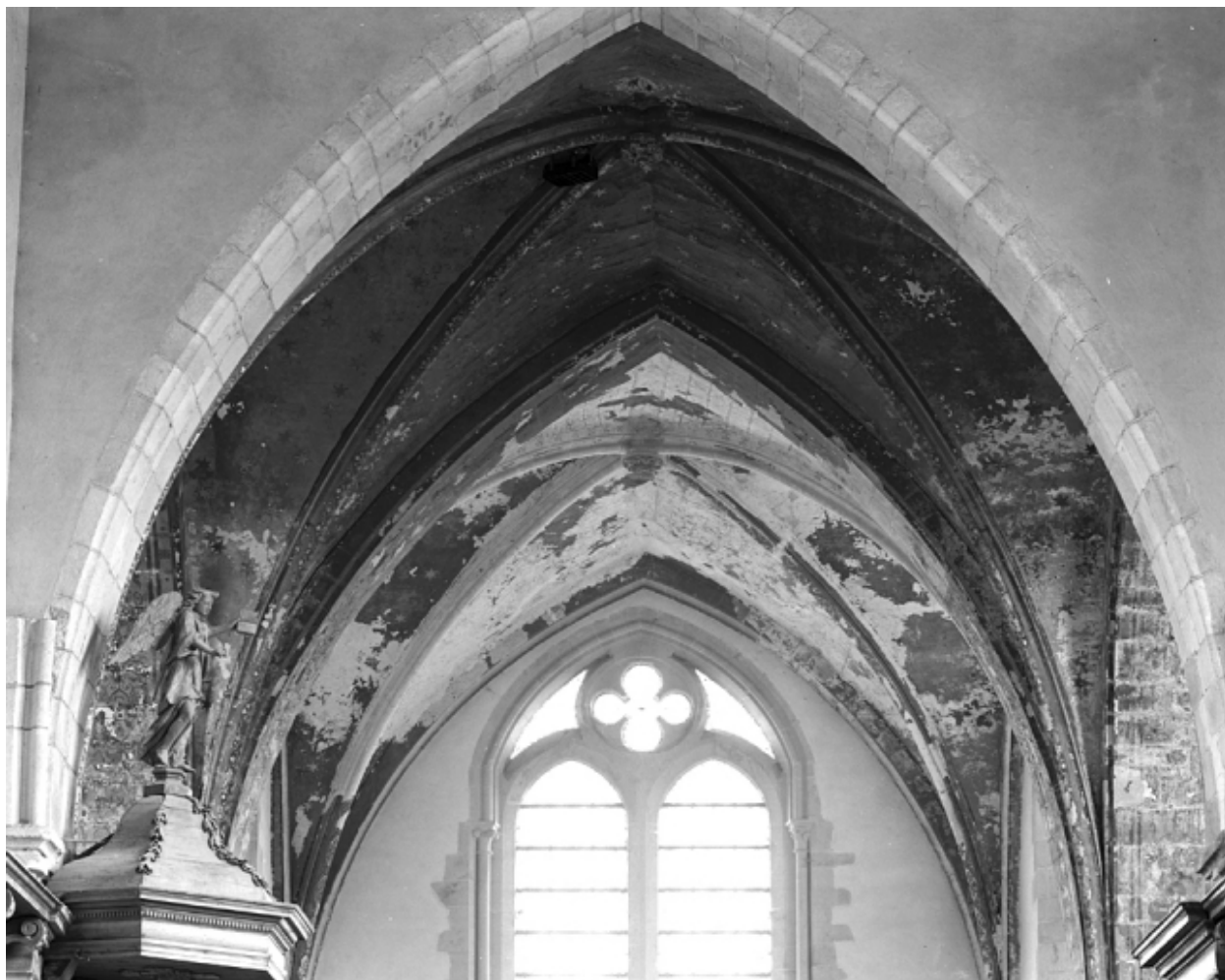
Eglise abbatiale ; vue intérieure : voûtes du choeur
