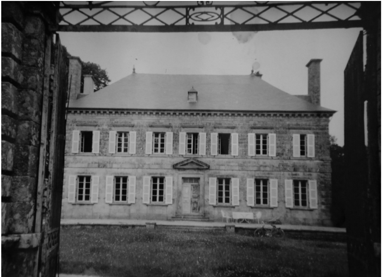
Vue rapprochée du corps de logis
