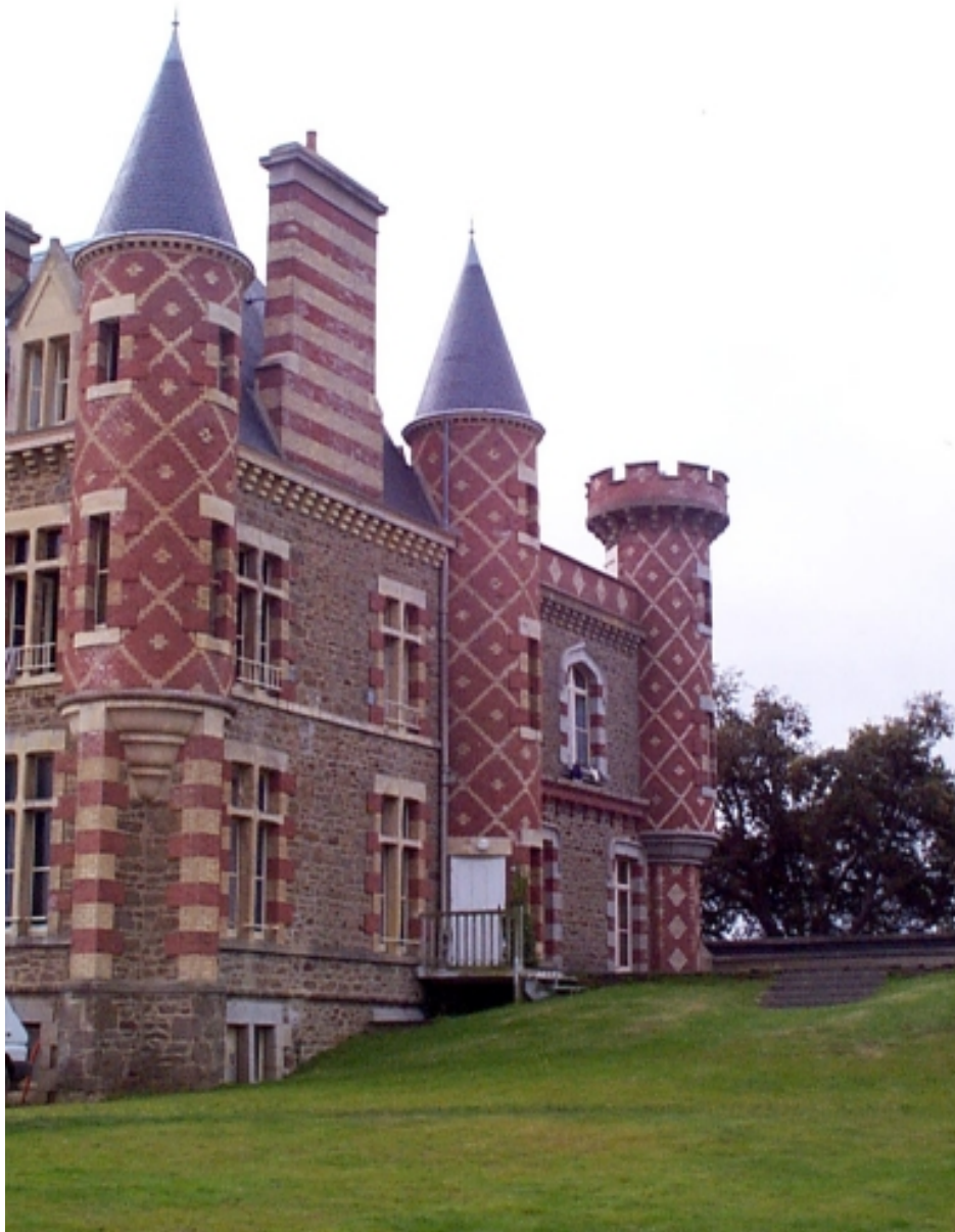
Elévation nord-ouest : vue générale
