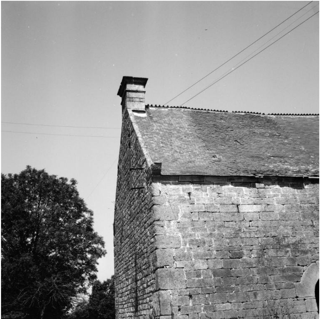
Maison II : détail de l'angle sud-ouest
