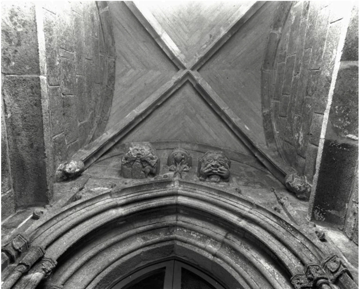
Porche Nord : détail des trois supports de statues.
