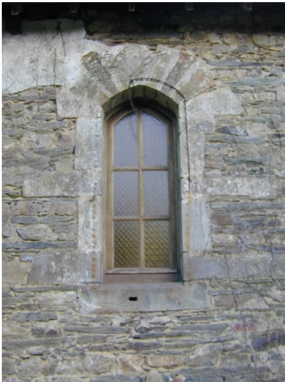
Baie nord : vue générale
