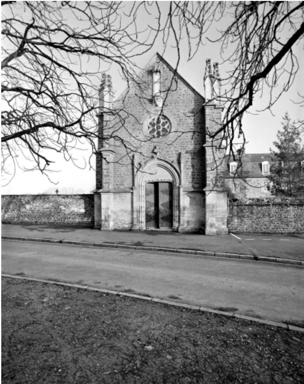
Elévation ouest : vue générale
