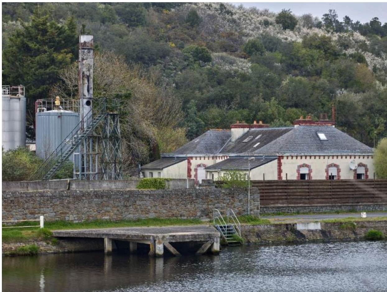
Vue de situation de la maison des éclusiers
