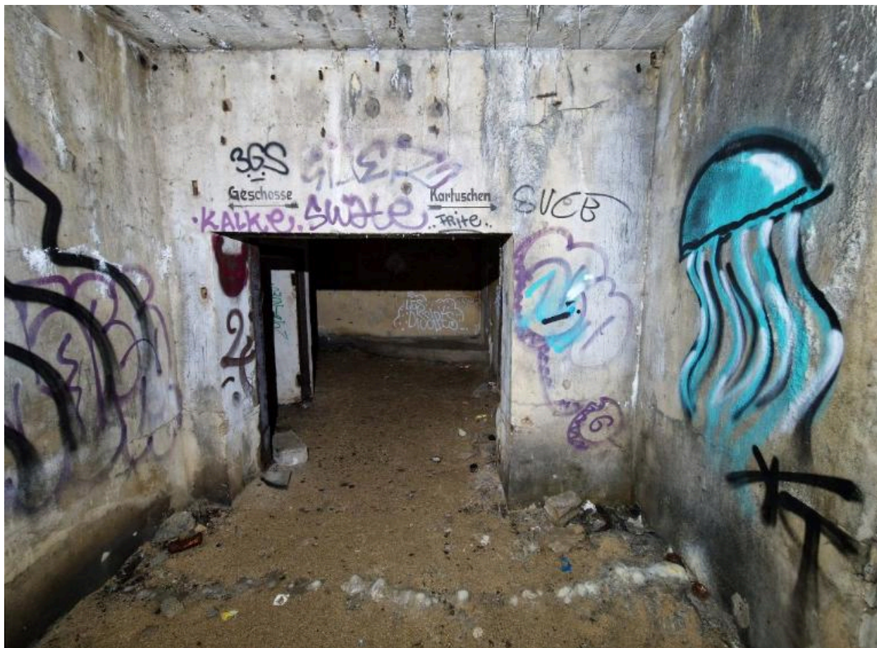
Vue intérieure du bunker - cuve nord pour canon de 34 cm avec magasins de munitions. Ce bunker conserve des marquages
