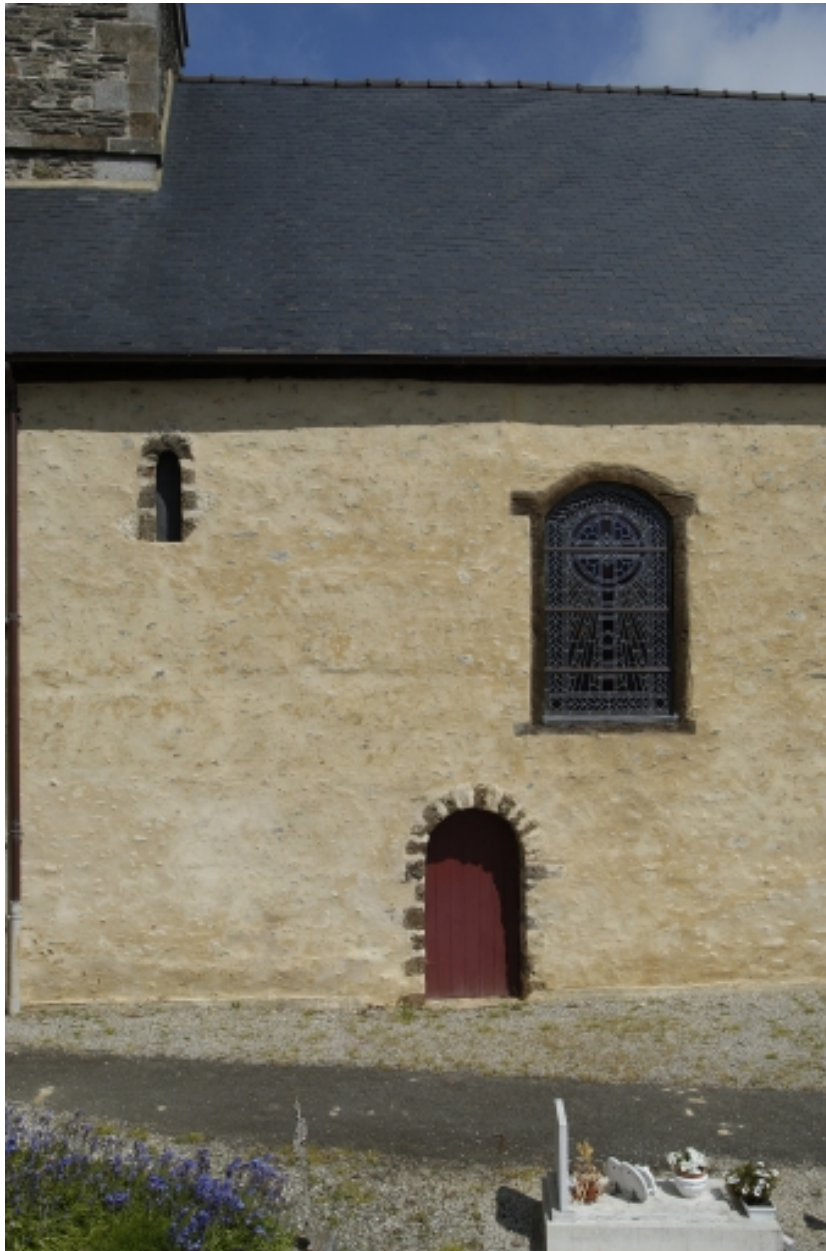
Détail des baies de la façade sud
