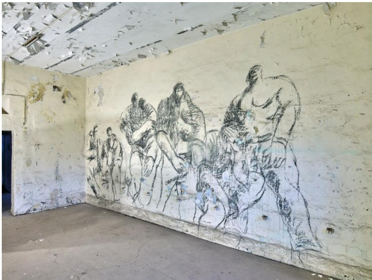
Vue de l'une des cellules du deuxième étage (plafond en voûtain de brique et poutrelles). Sur le mur de droite, une oeuvre de Paul Bloas
