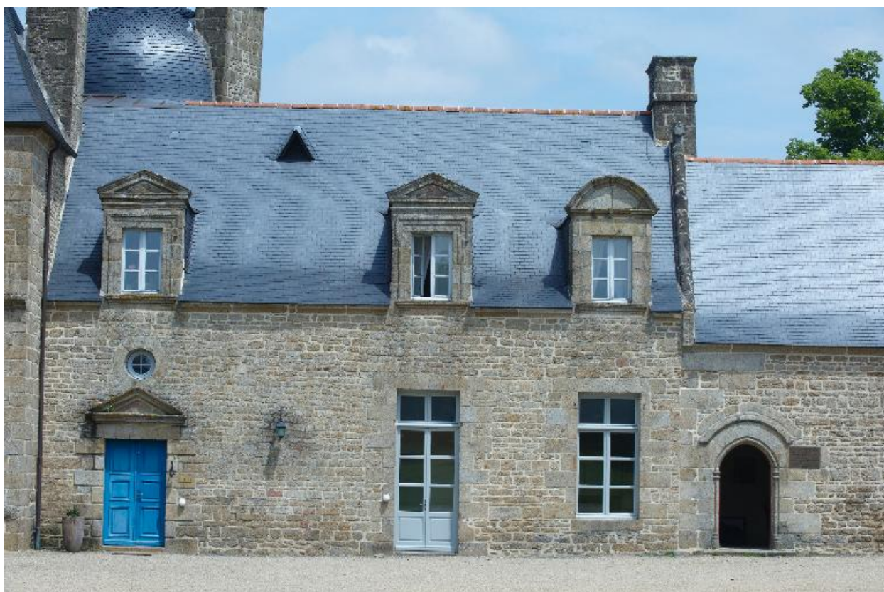
Vue rapprochée, façade sud
