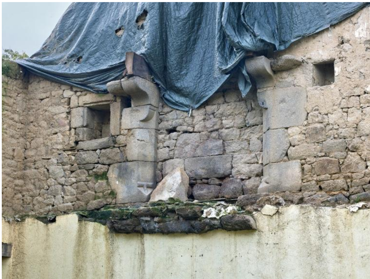
Vestiges. Etage, pignon ouest. Cheminée à tablettes latérales
