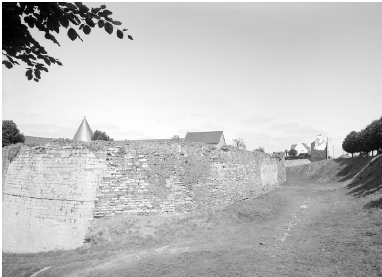
Chemise est et fossé, vue générale sud-est.
