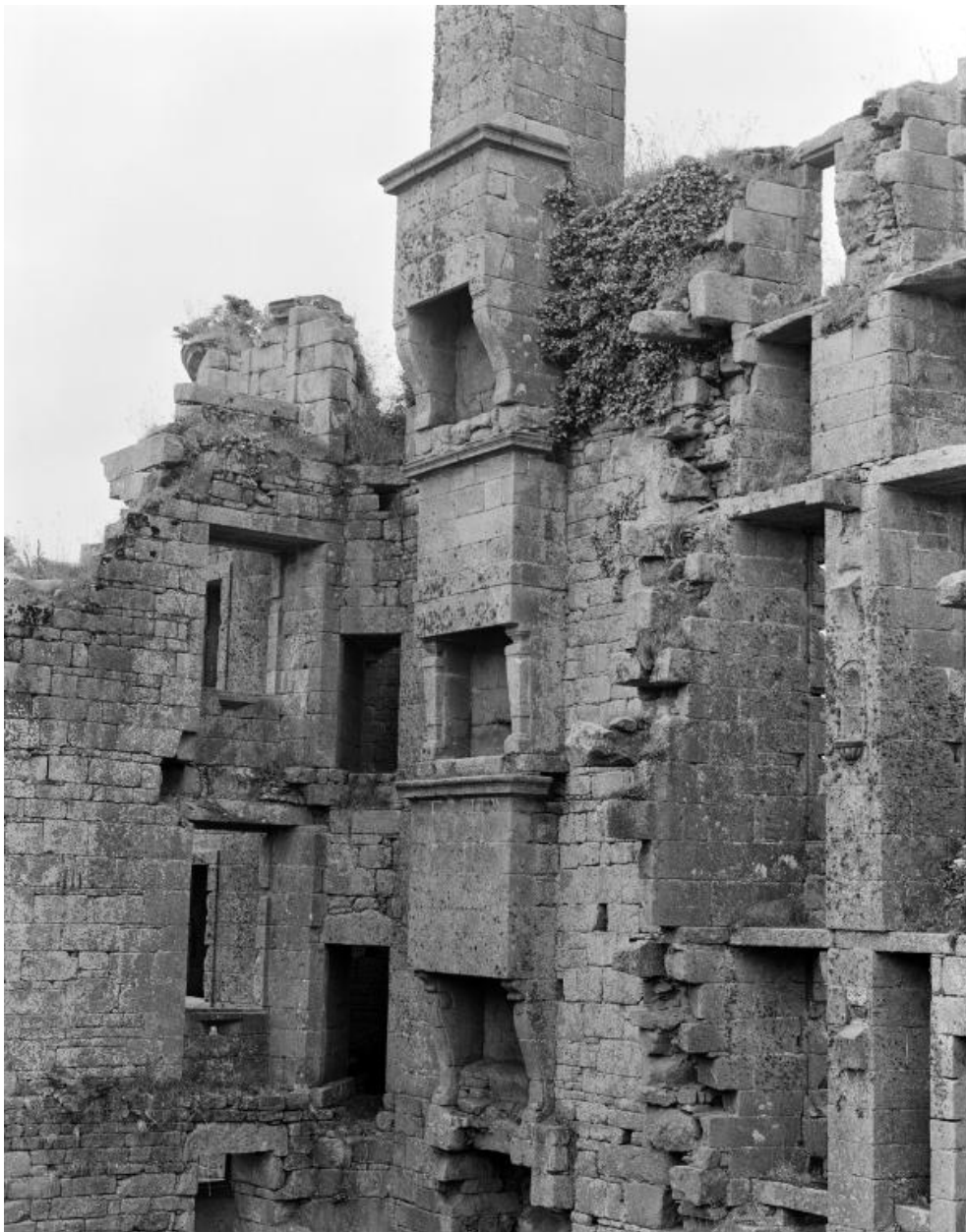
Vue du mur intérieur de la courtine sud-ouest depuis le nord : superposition des cheminées des rez-de-chaussée, premier étage et étage de comble (état en 1986)
