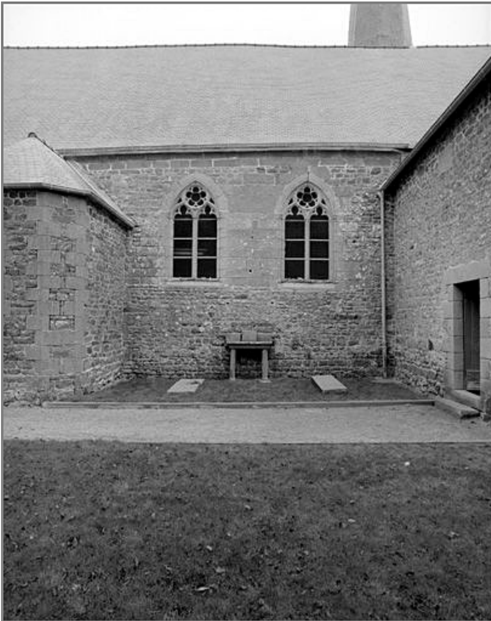
Elévation sud, partie centrale : vue générale avant restauration
