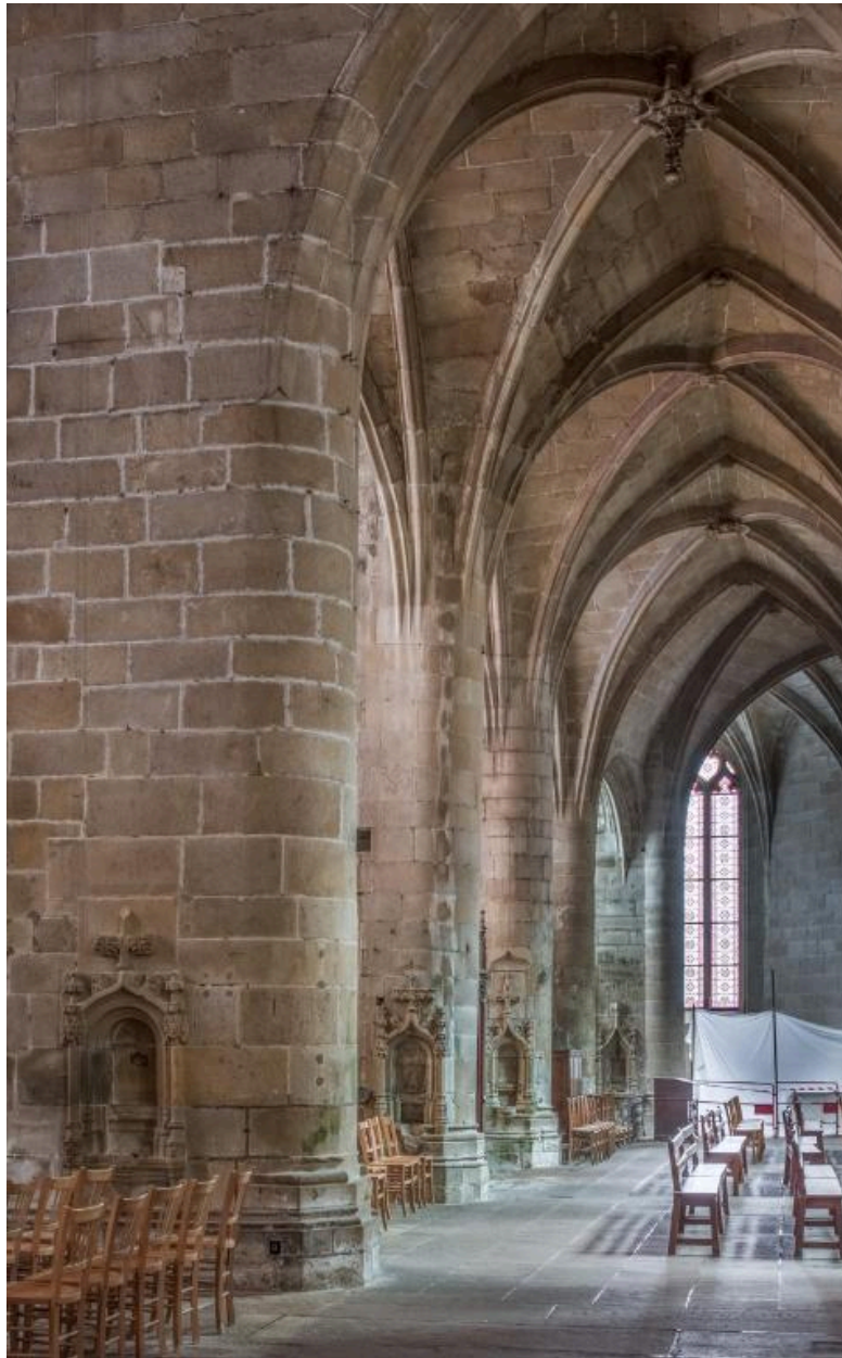
Déambulatoire du choeur côté nord avec l'enfilade des chapelles
