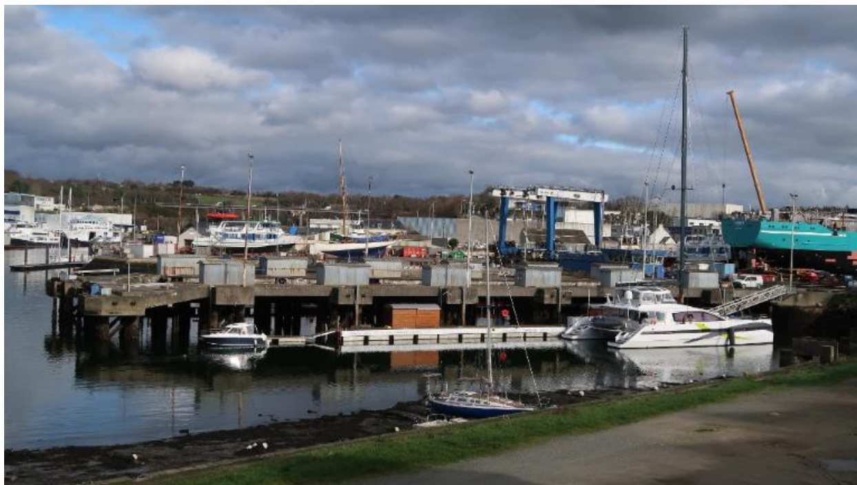
Aire de réparation navale
