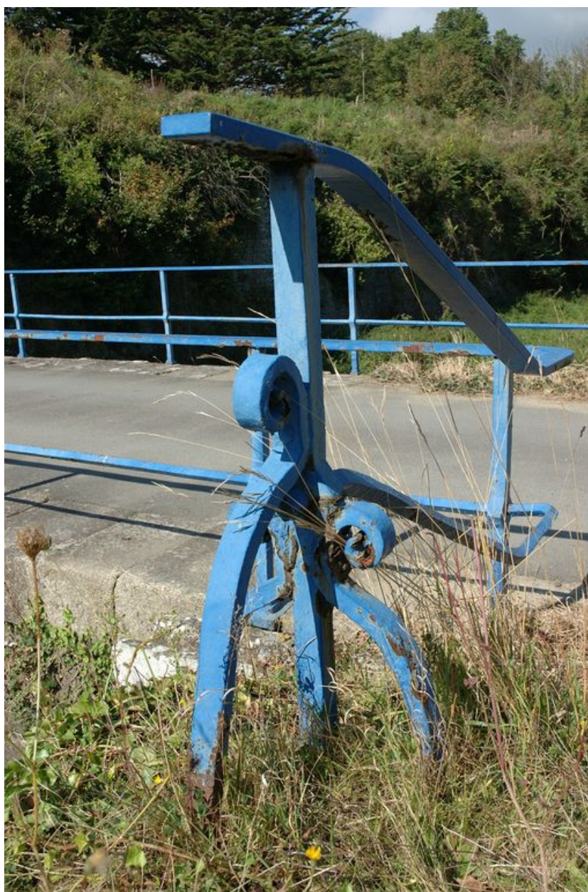
Vue de l'entrée monumentale : garde-corps en ferronnerie
