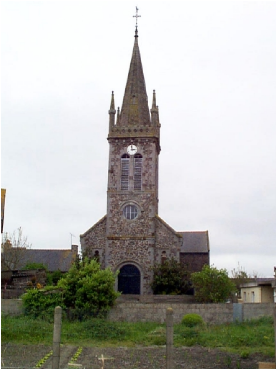
Elévation ouest : vue générale
