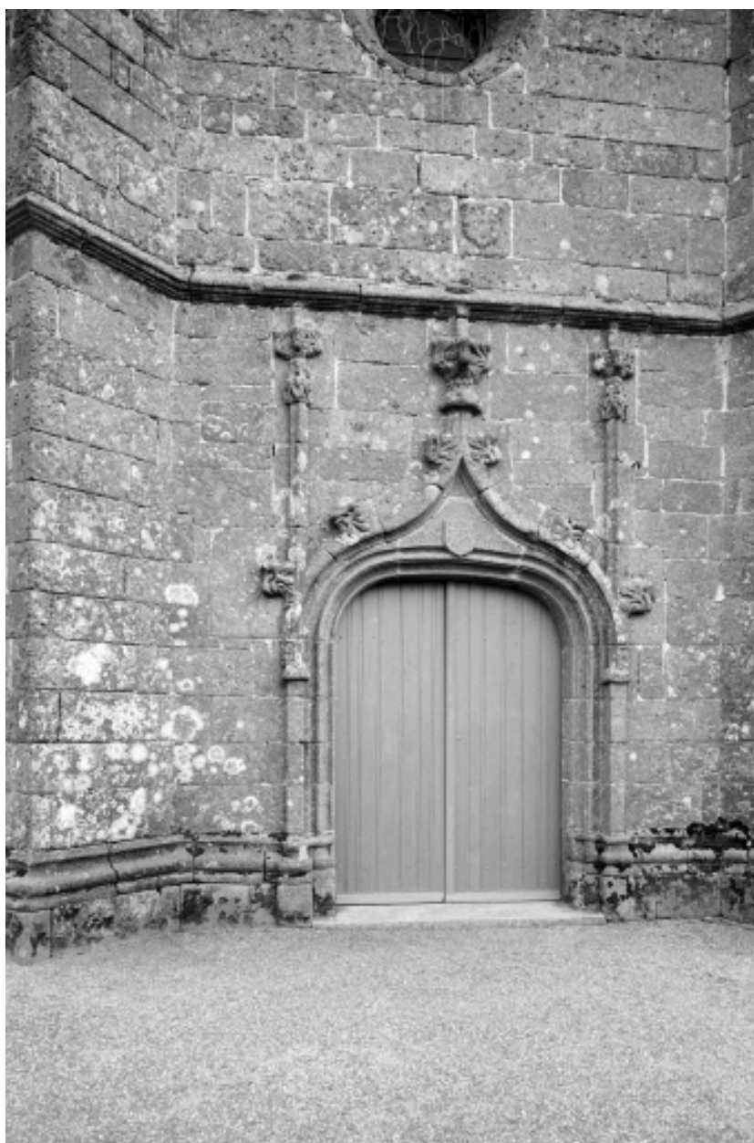
Façade ouest, détail porte.
