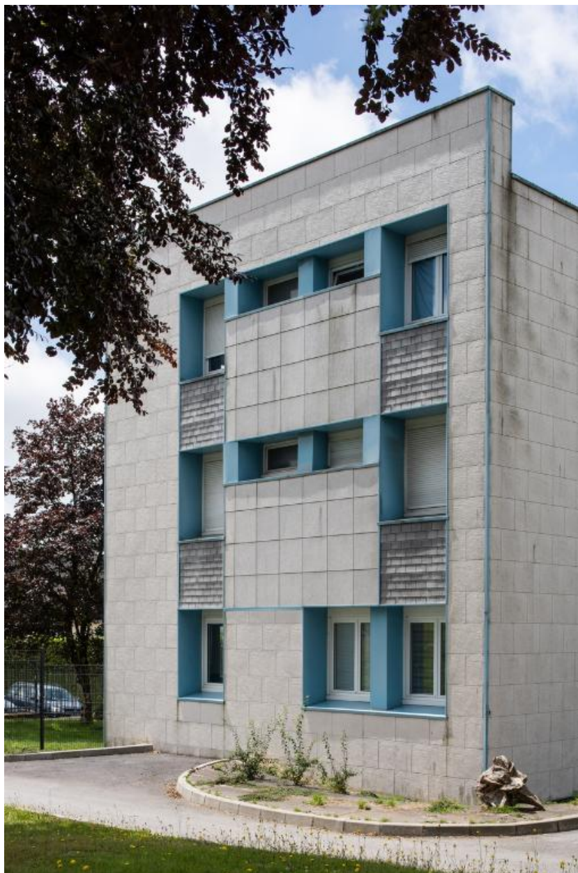
Administration, pignon est. Péron et Weisbein, architectes, 1967-1968.
