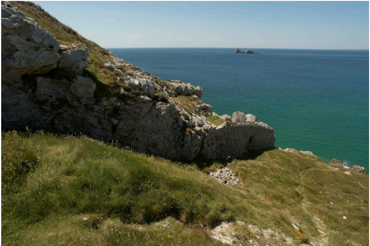
Vue de l'extrémité de la batterie de mortier : mur réalisé par déroctage de la falaise
