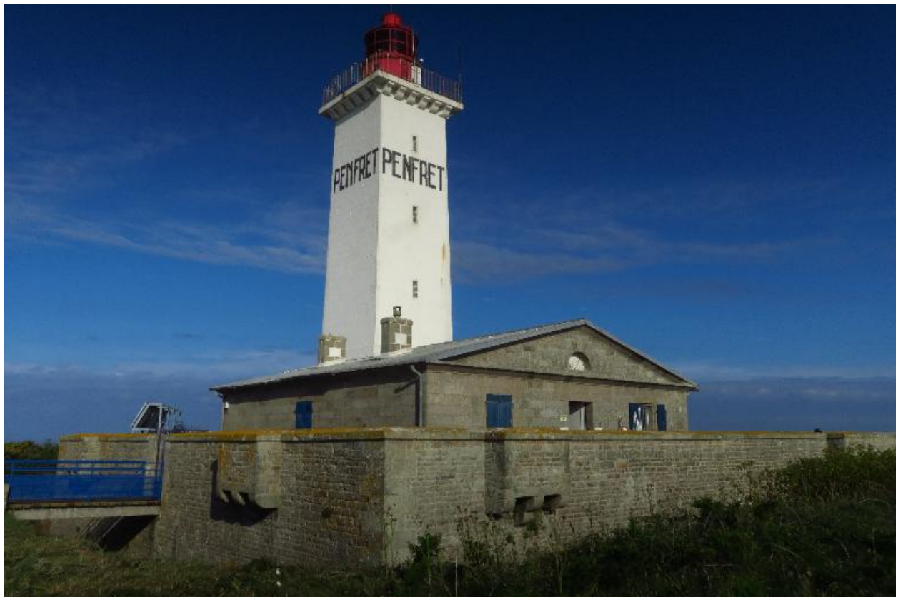
Archipel de Glénan, batterie de Penfret, réduit, angle sud-est.
