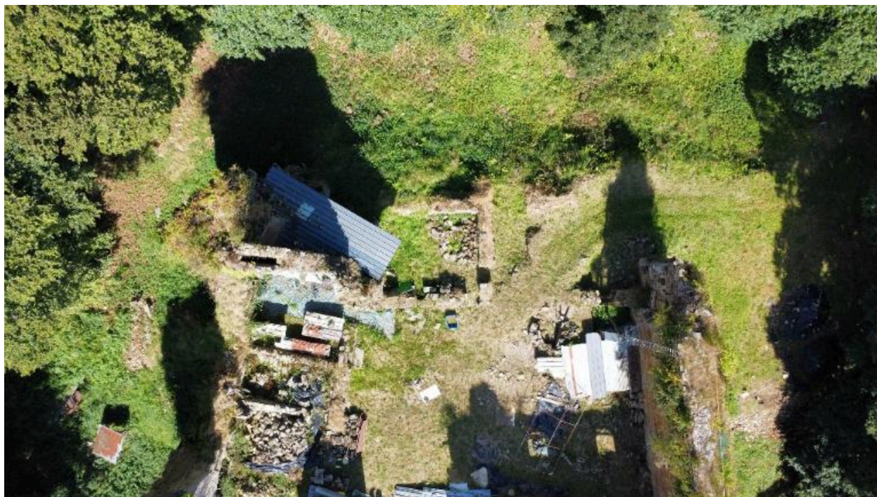
Vue aérienne verticale : logis-porche - châtelet nord. Son état est ruiniforme
