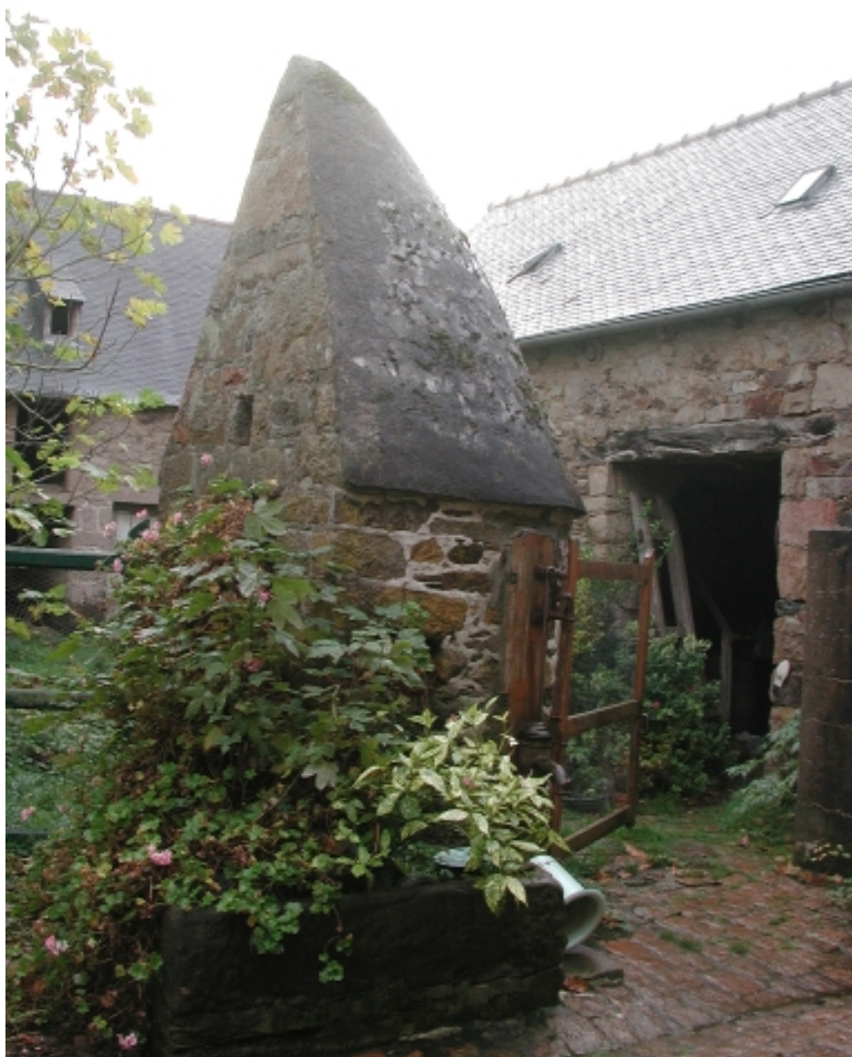
Vue du puits de Kerroc'h
