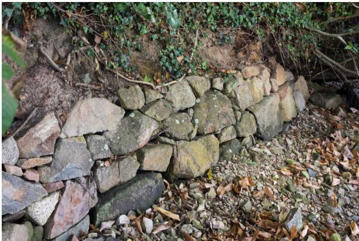
Vue d'un mur de soutènement sur la rive ouest de la baie de l'Enfer
