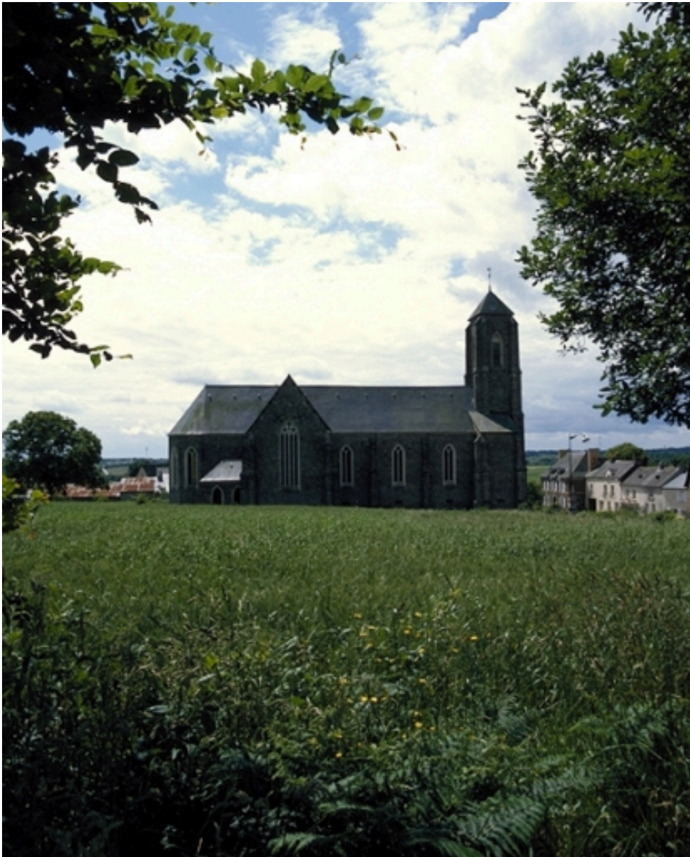
Vue générale nord
