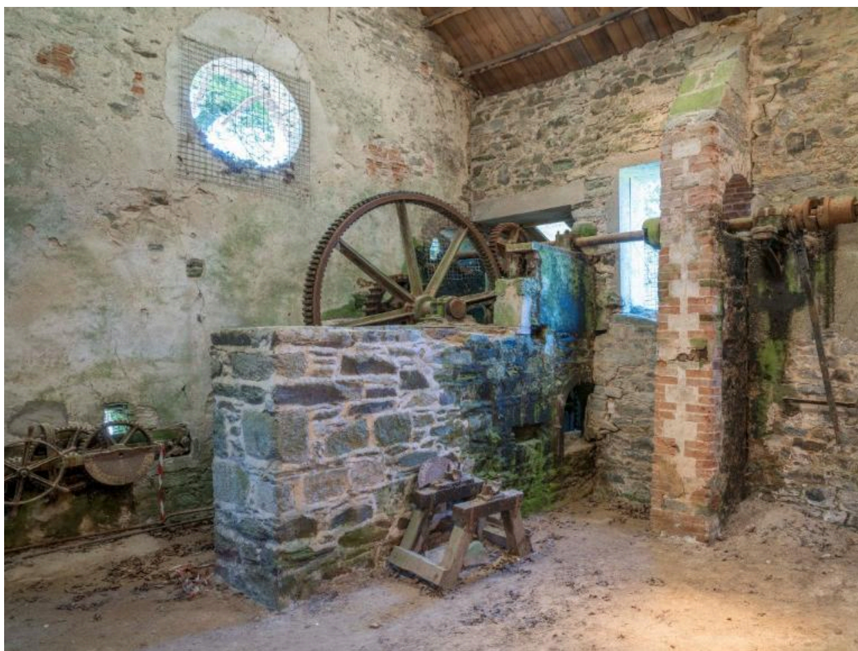
Bâtiment principal. Salle 1. Roue motrice
