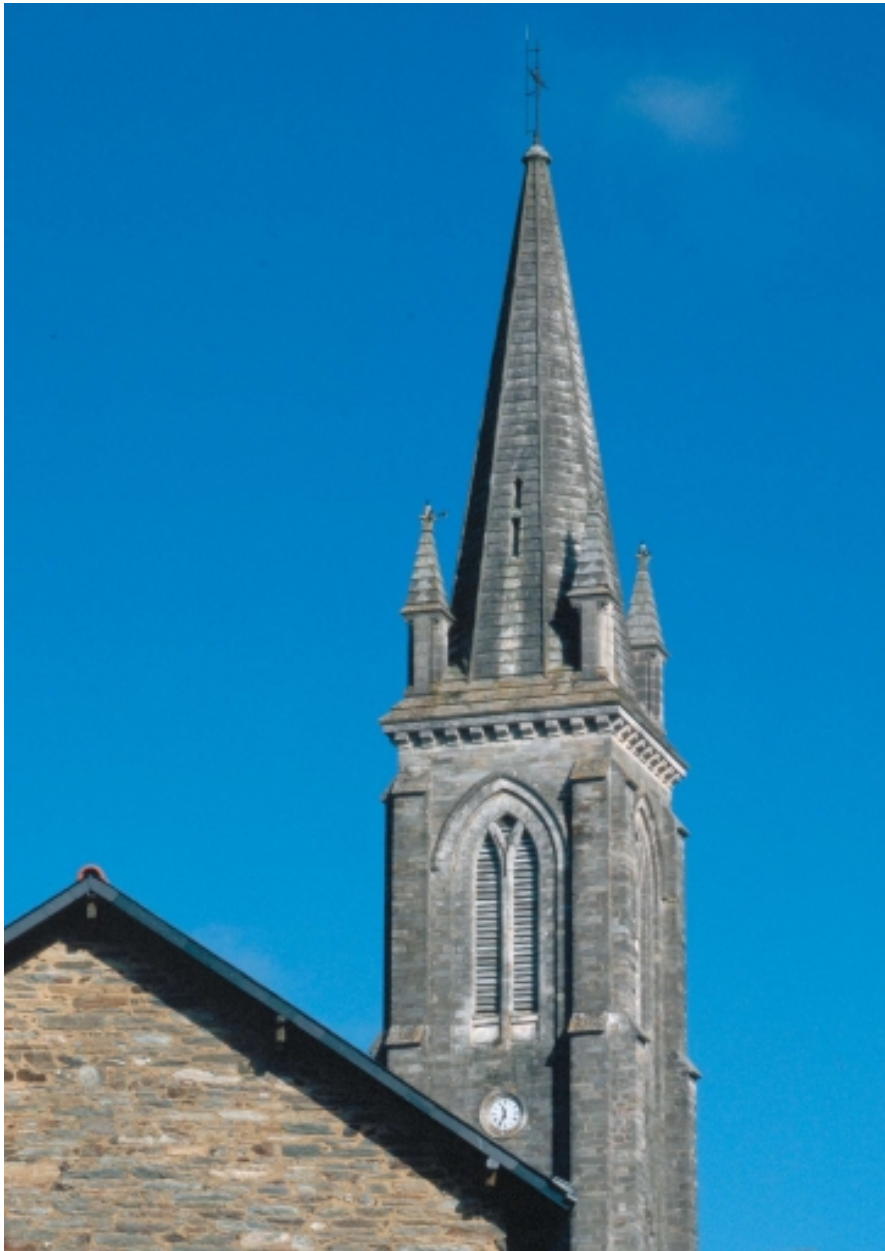
Le clocher : vue générale est
