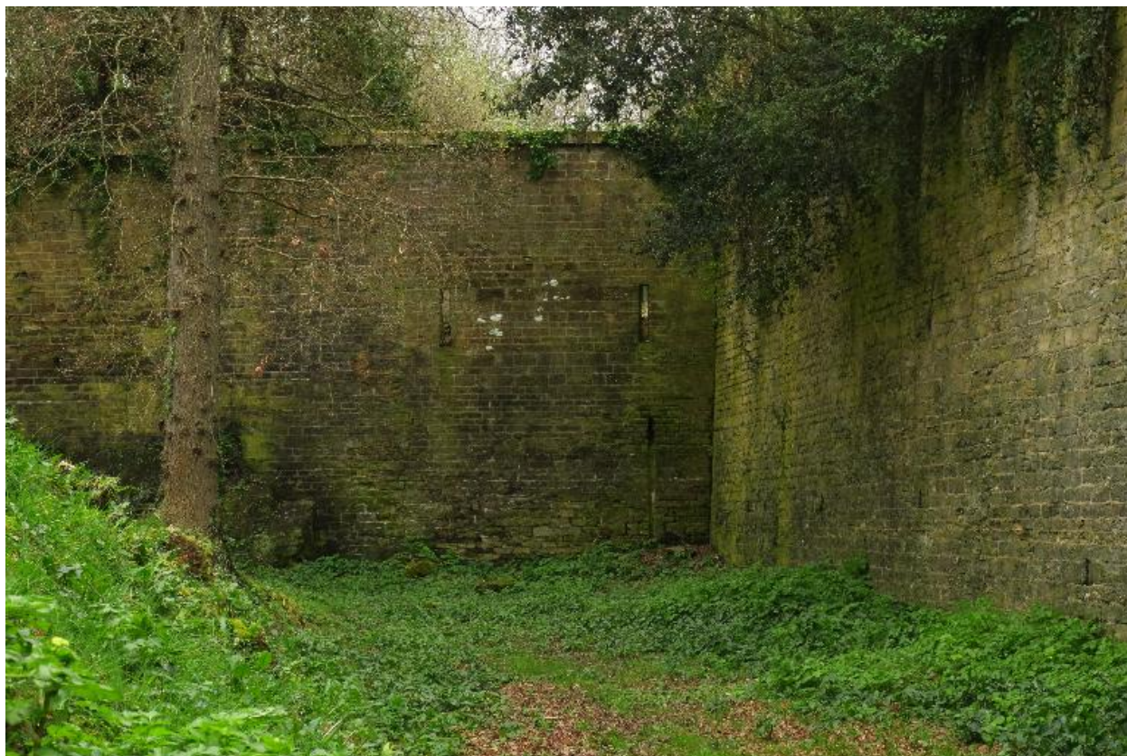
Le Palais, enceinte urbaine, bastion 20, flanc gauche, mur crénelé flanquant la courtine 19-20.
