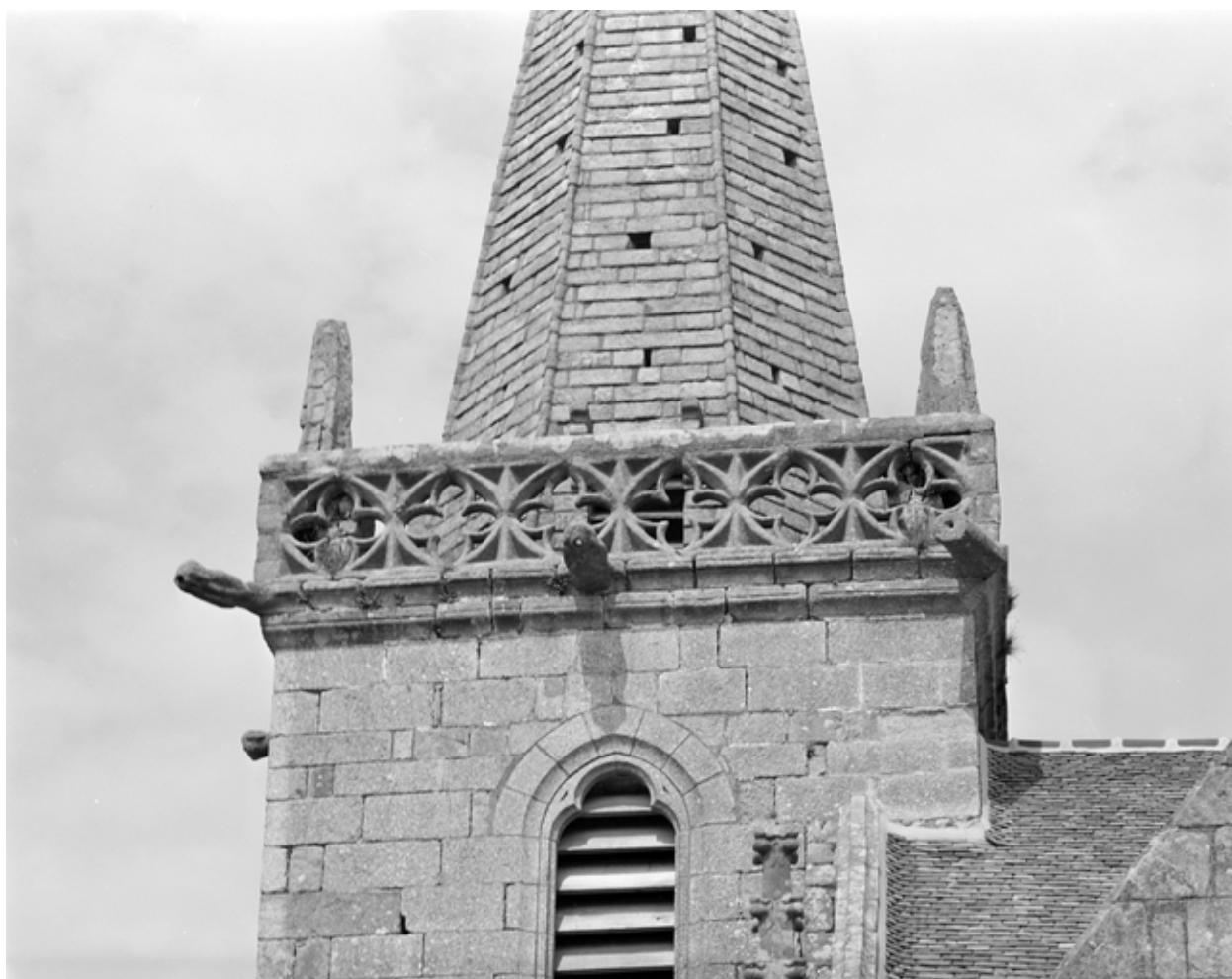
Détail de la balustrade du clocher côté sud
