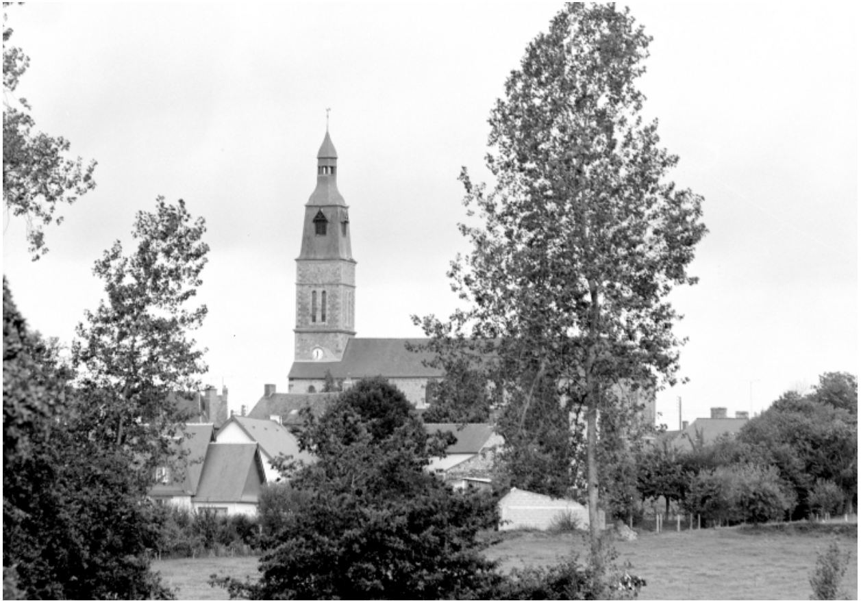
Vue générale sud.
