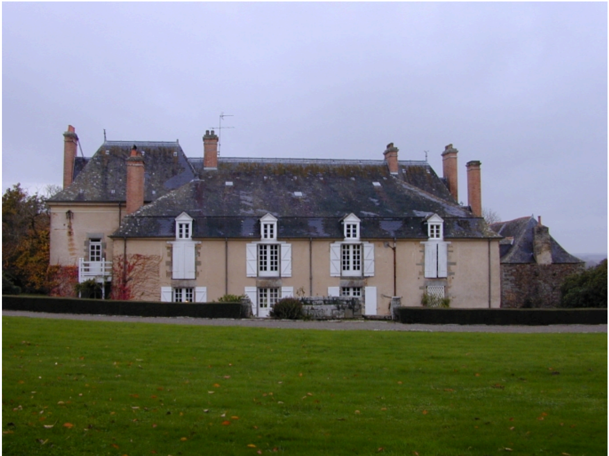
Corps principal, ancien logis, façade postérieure : vue générale nord-est
