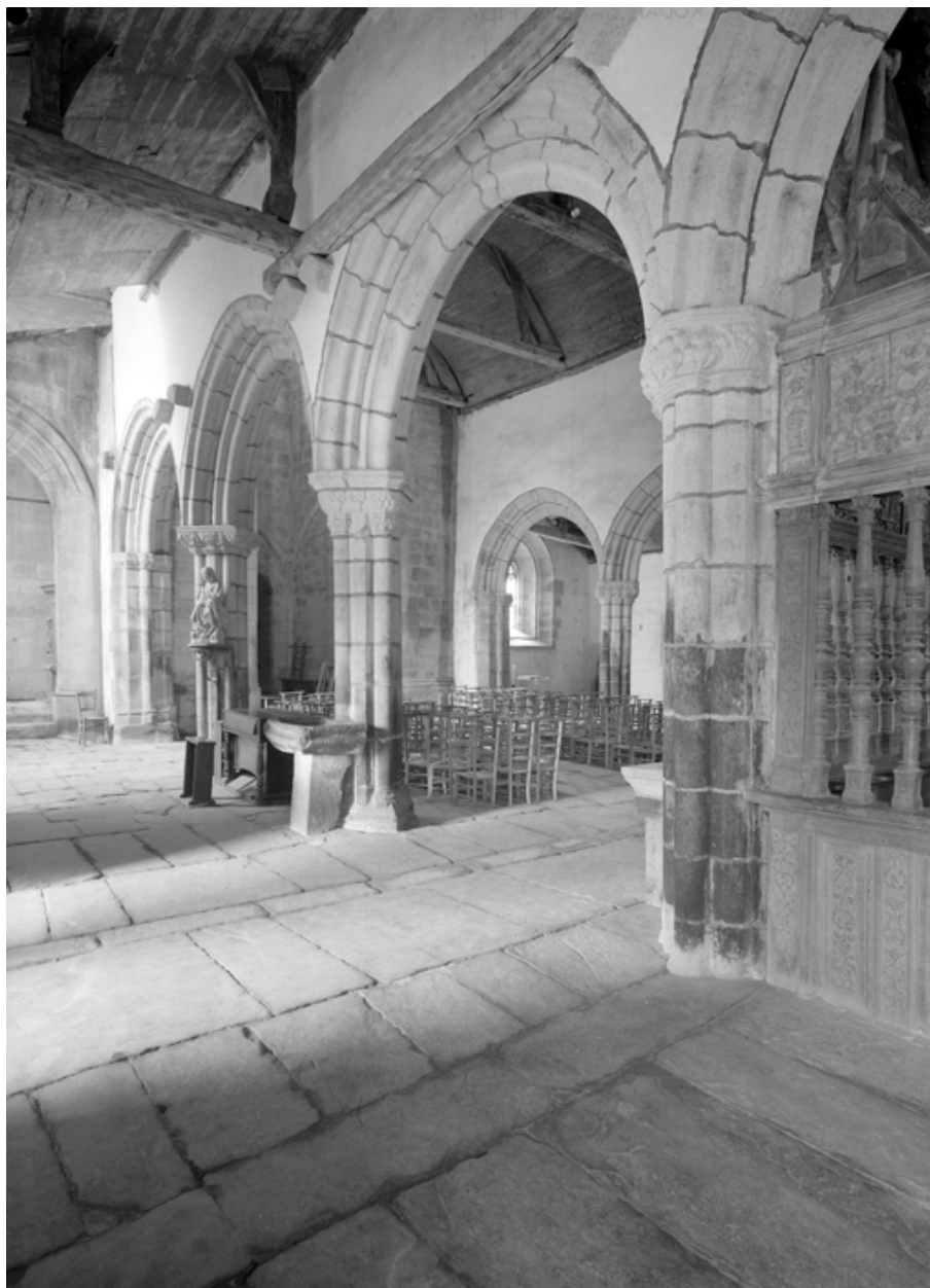
Arcades du collatéral sud, vue générale prise du sud-est
