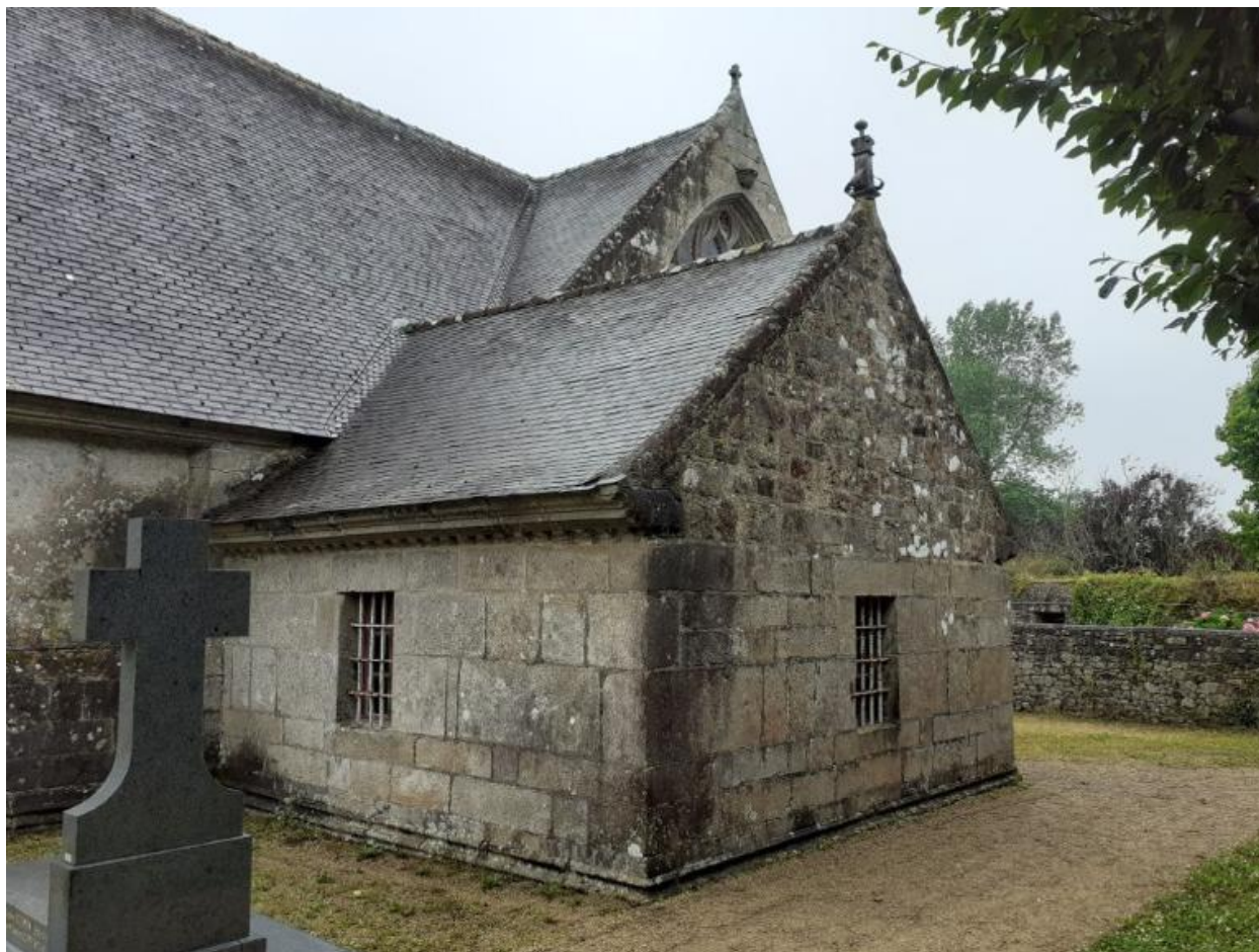
Sacristie, vue depuis le sud-est
