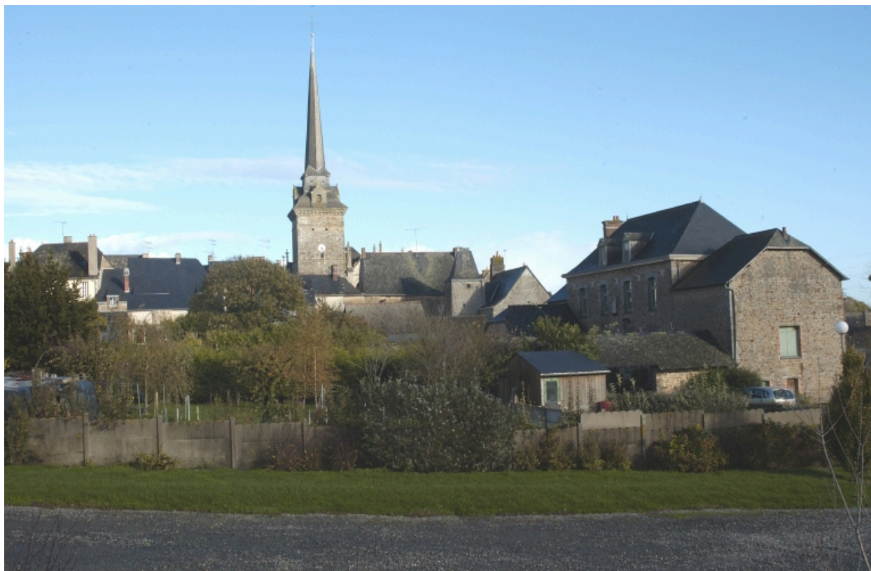
Vue de situation ouest
