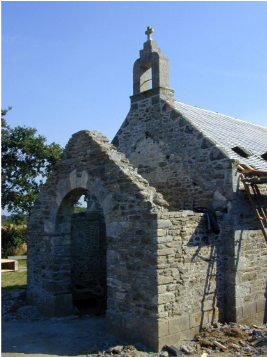
Le porche en cours de restauration : vue générale sud-ouest
