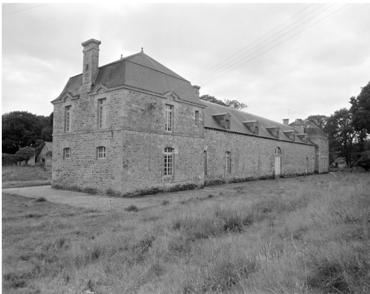
Communs : vue d'un pavillon d'angle (sud-est)
