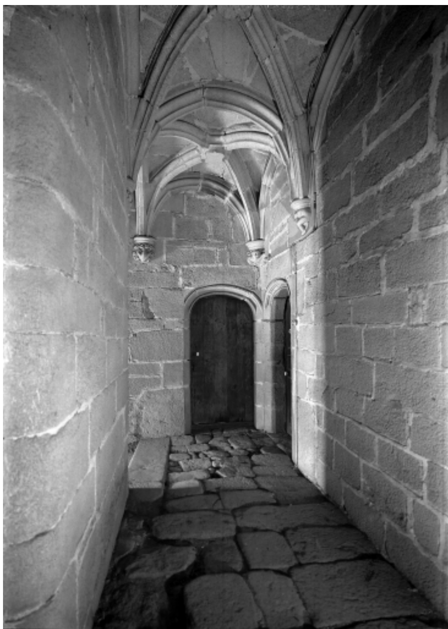
Escalier, 1er étage : vue axiale ouest est du palier
