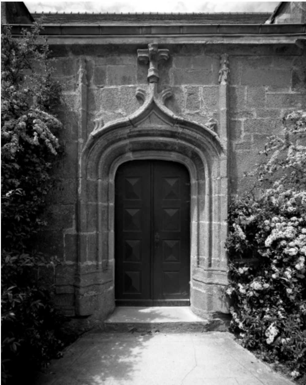
Plomodiern, église paroissiale Saint-Mahouarn : façade sud, porte du bas-côté, état en 1972
