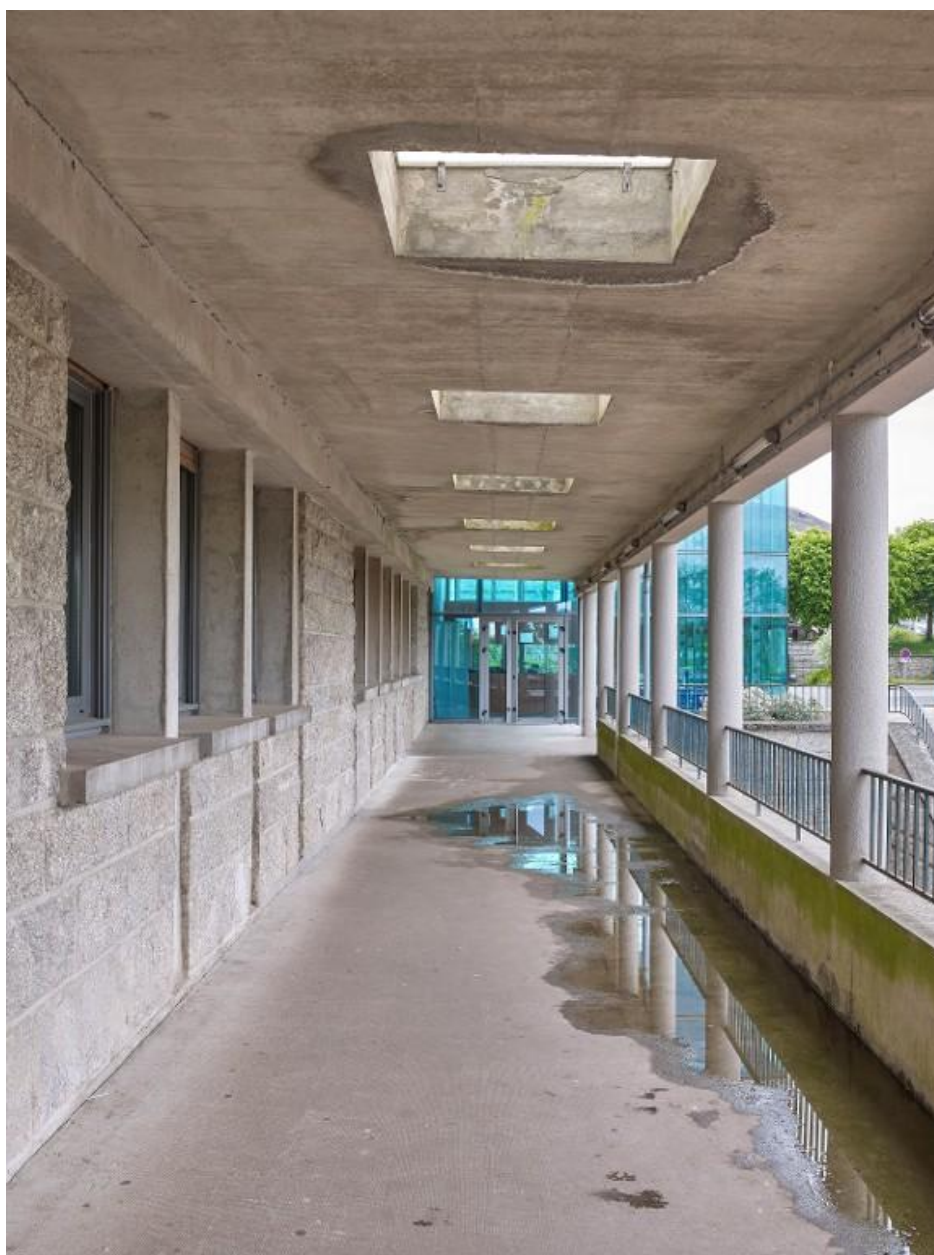
Galerie de circulation (2e niveau) vers le hall d'accueil.
