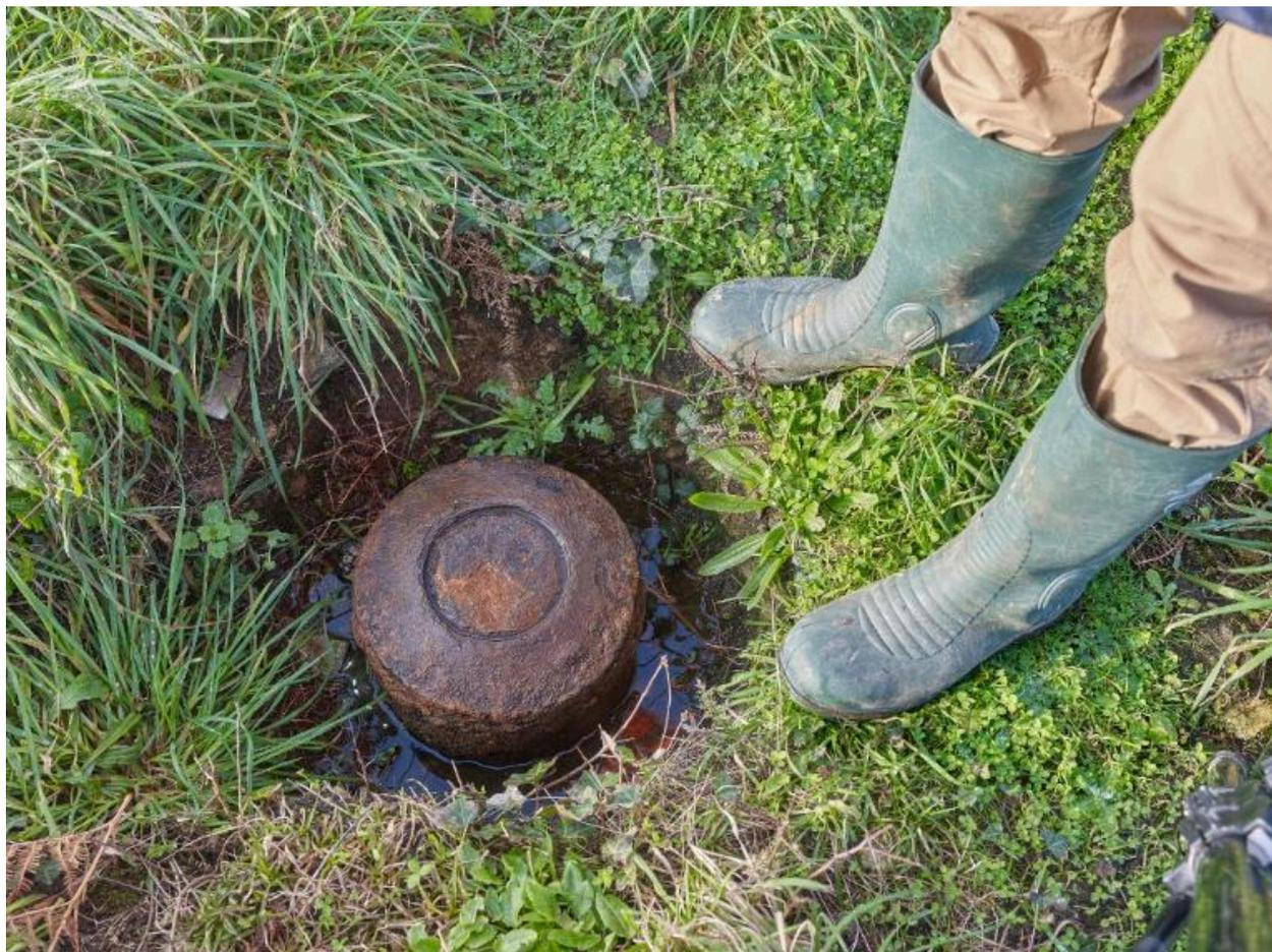
Vue du débouché du puits de périscope sur la dalle de couverture de 2 m d'épaisseur. Il a conservé son bouchon obturateur
