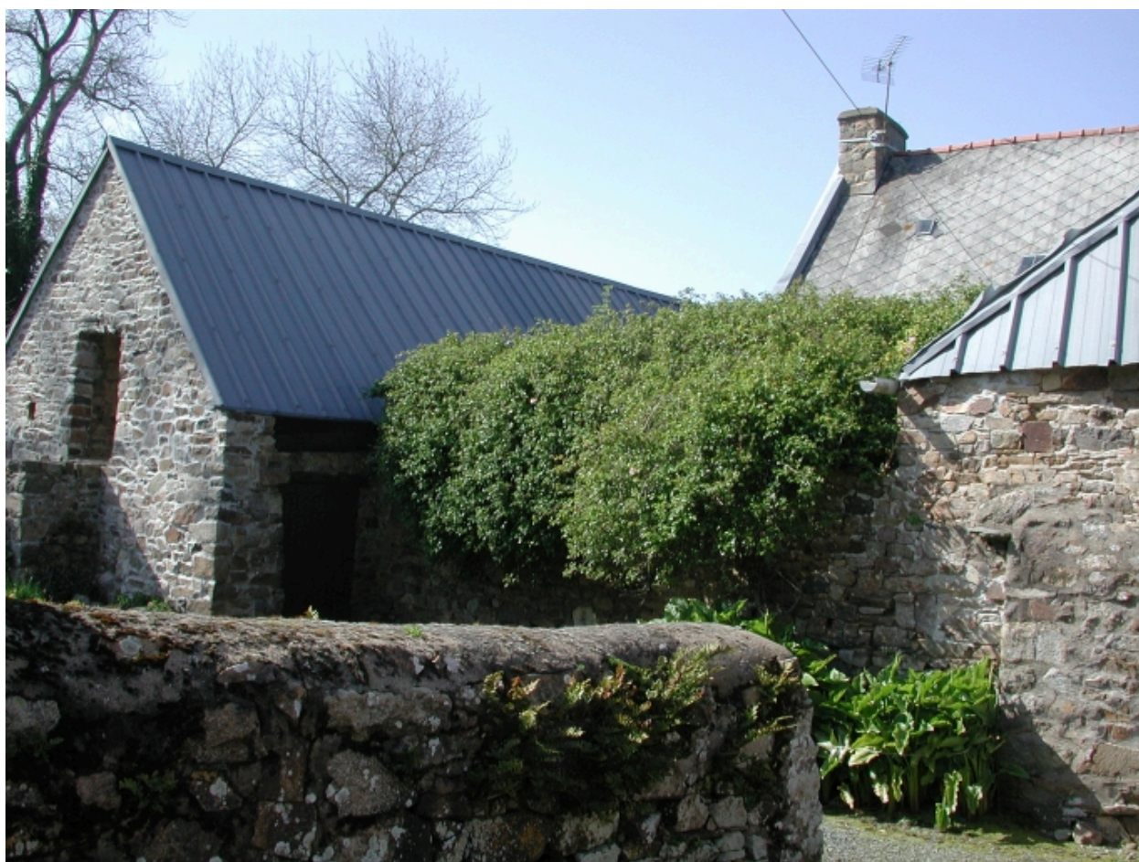
Vue extérieure de la cour fermée
