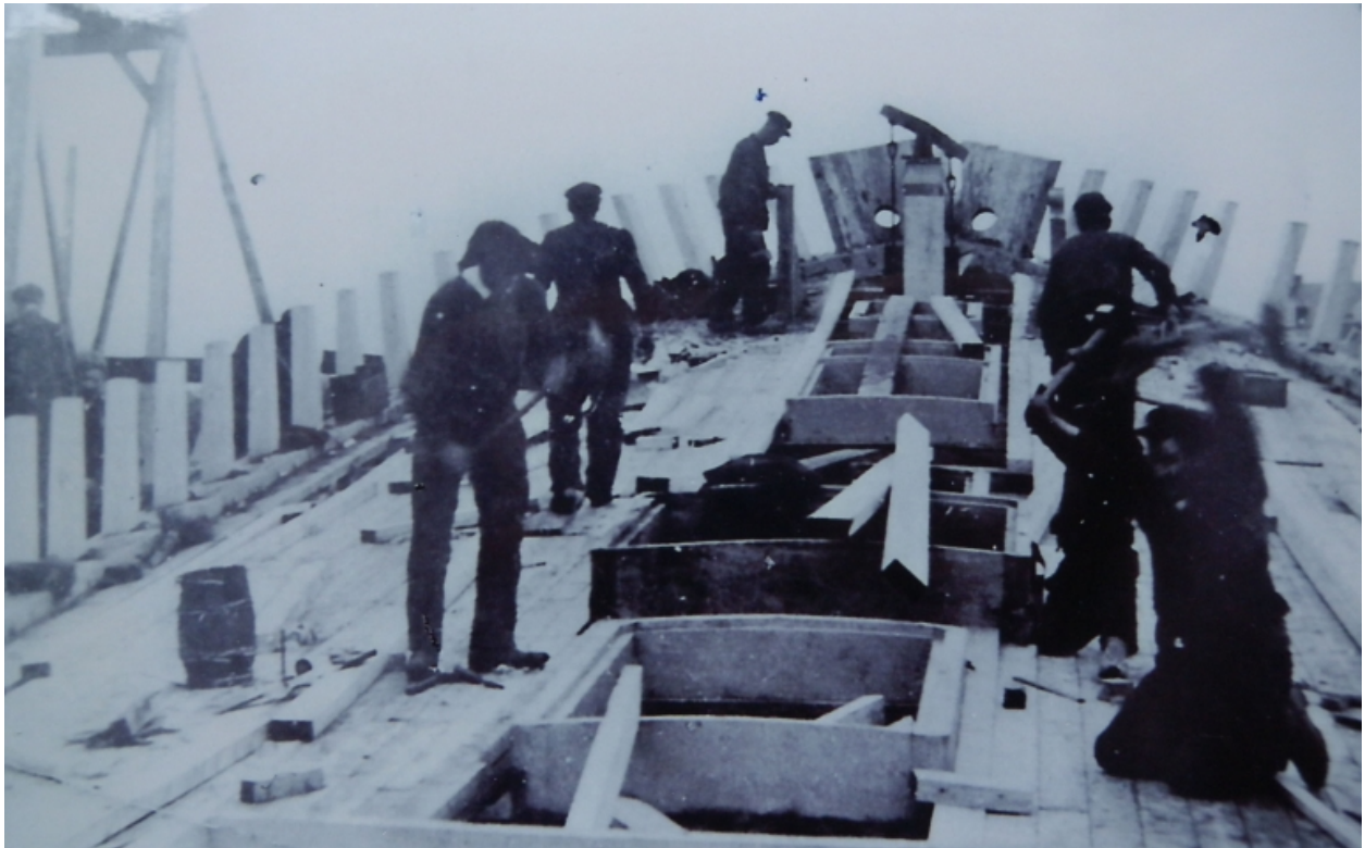
Emile Bonne avec ses ouvriers sur le pont d'un vaire en construction, 1er quart 20ème siècle (collection particulière)
