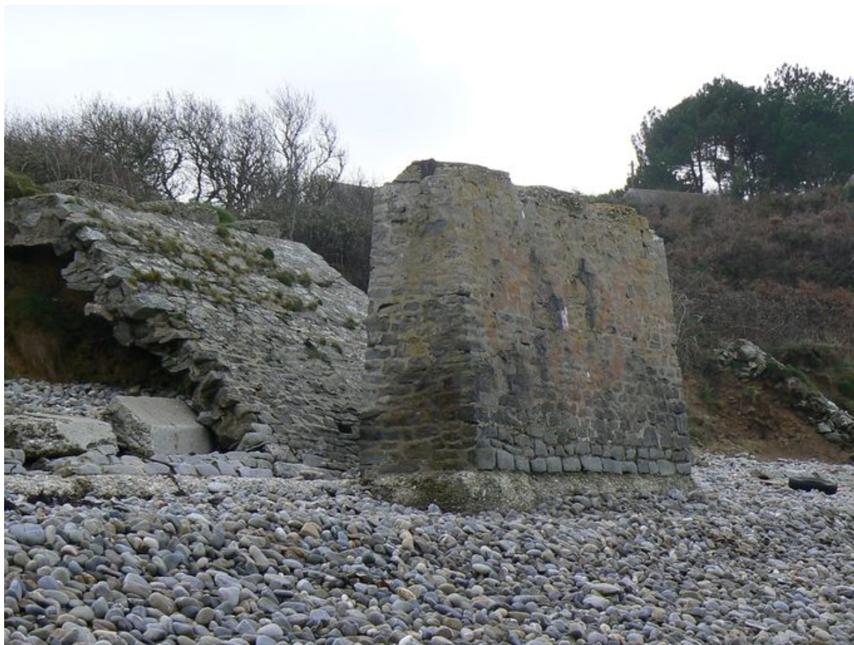
Vestiges de l'annexe du centre d'aviation maritime
